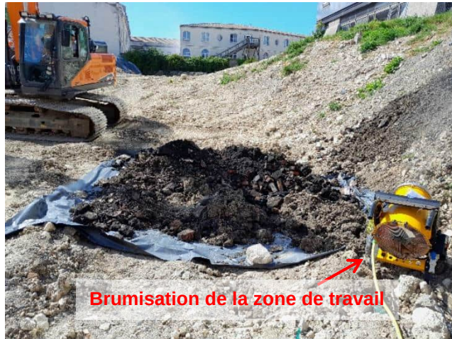
Terres excavées du sondage PP10 déposées sur une bâche étanche
